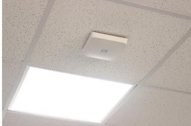
**Fig. 5.** Equipo de red inalámbrica. Foto: CTA-CUAAD
