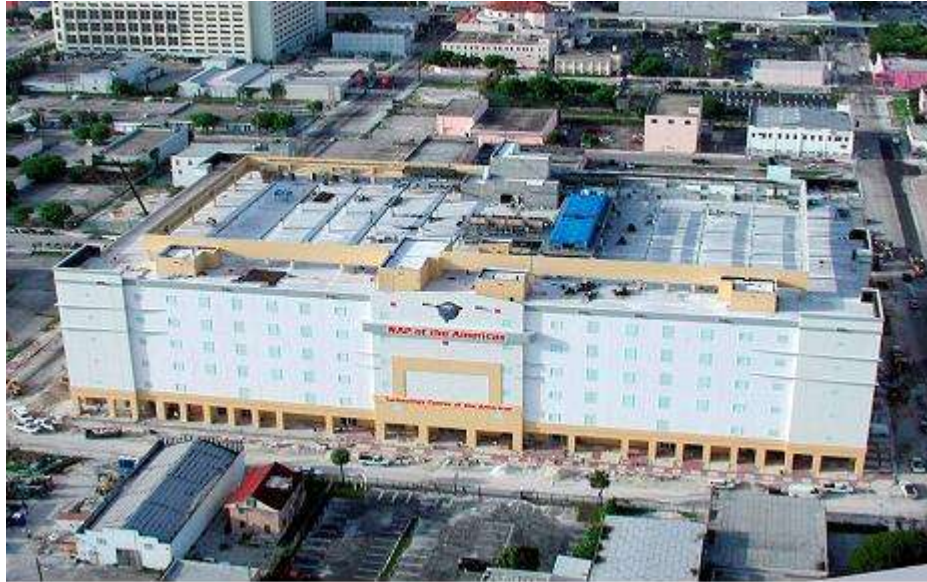
El NAP de las Américas es un punto de intercambio de servicios de Telecomunicaciones donde confluyen los cables submarinos más importantes de la Región.
